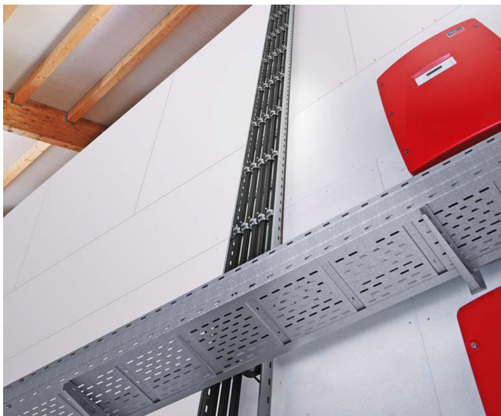
Bild 11: Leitungsführung am Wechselrichter
